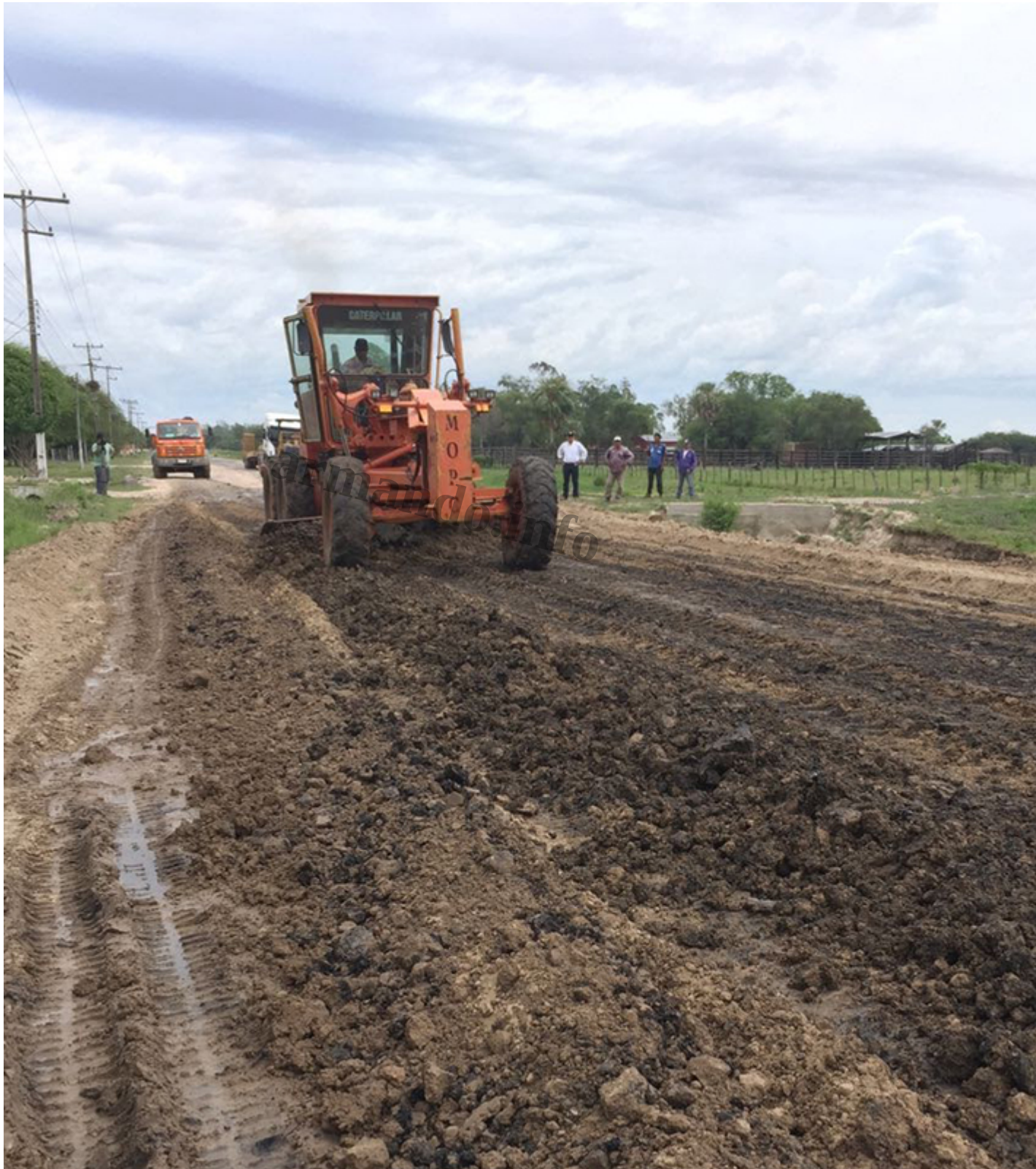
Proceso de pavimentación con el producto polyflex, que según el equipo de trabajo de FarÃa es ecológico y un 80% menos costoso que el asfalto convencional.
