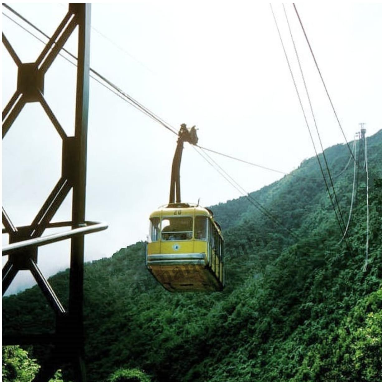
[Las cabinas empleadas en el sistema teleférico Caracas - Litoral \(1955 / 1956\) fueron diseñados por la firma Ernest Heckel y tenían capacidad para 24 personas sentadas. Fuente: Archivo del teleférico del Ávila.](#)
