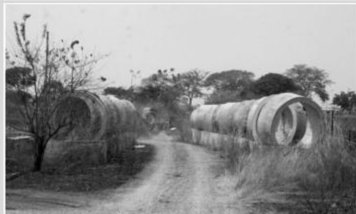
Estas estructuras de concreto que iban a ser colocadas se encuentran abandonadas en el sitio, son pérdidas millonarias para la nación.
