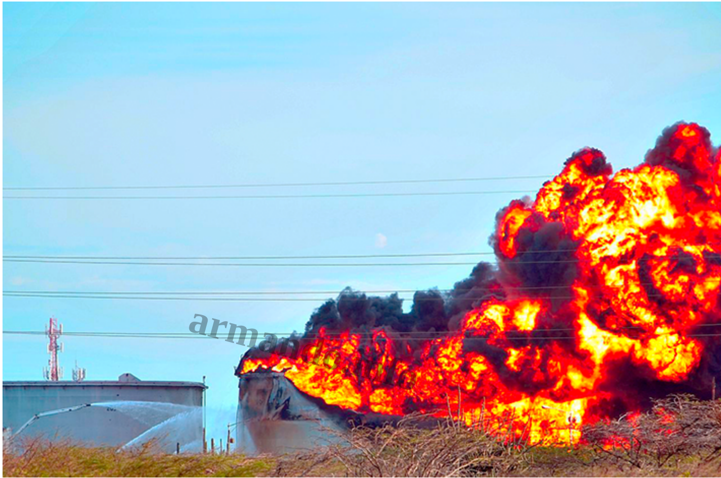
Incendio en uno de los tanques despu s de la explosi n
