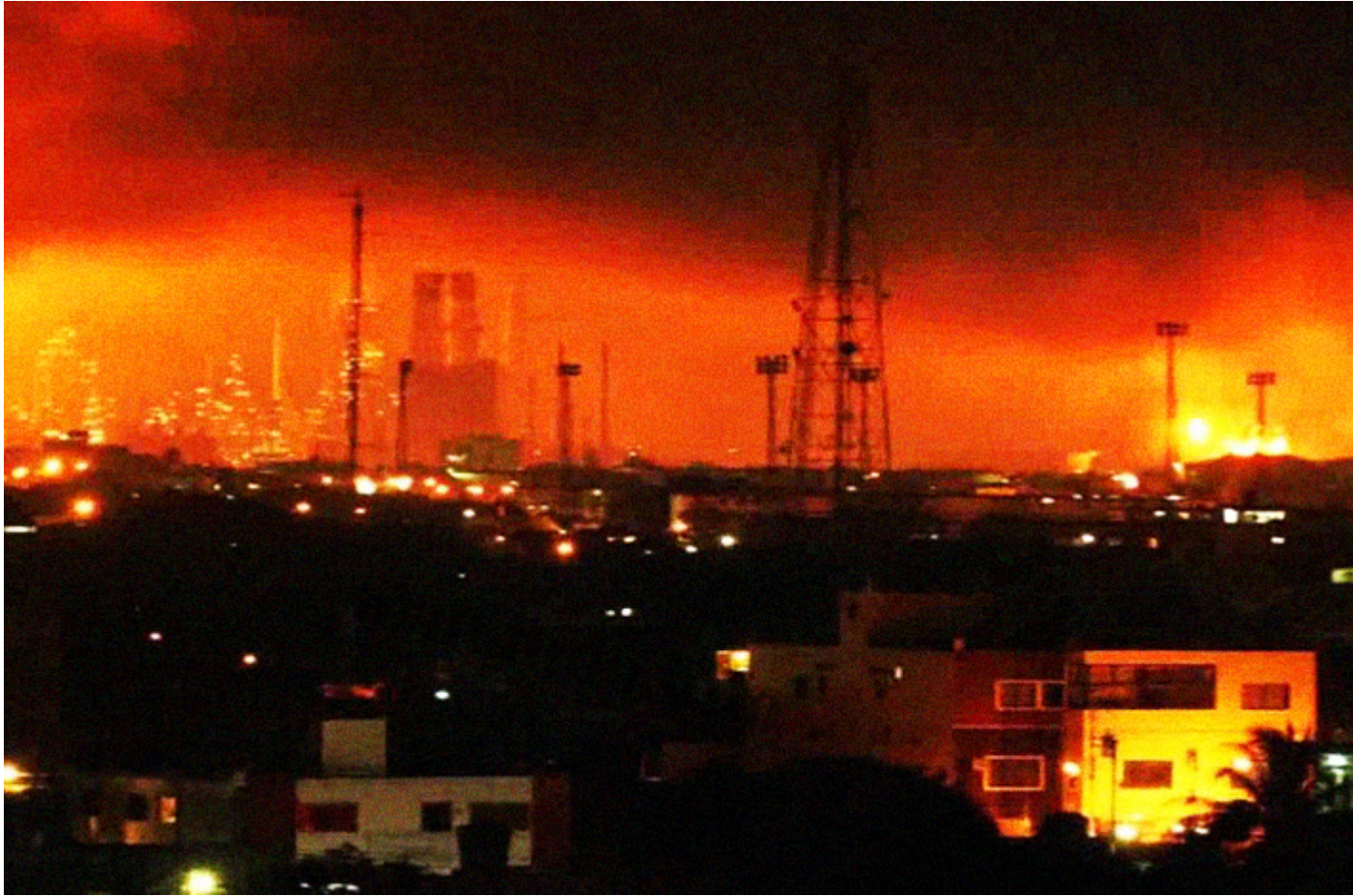
Vista del incendio causado por la explosi3n.
