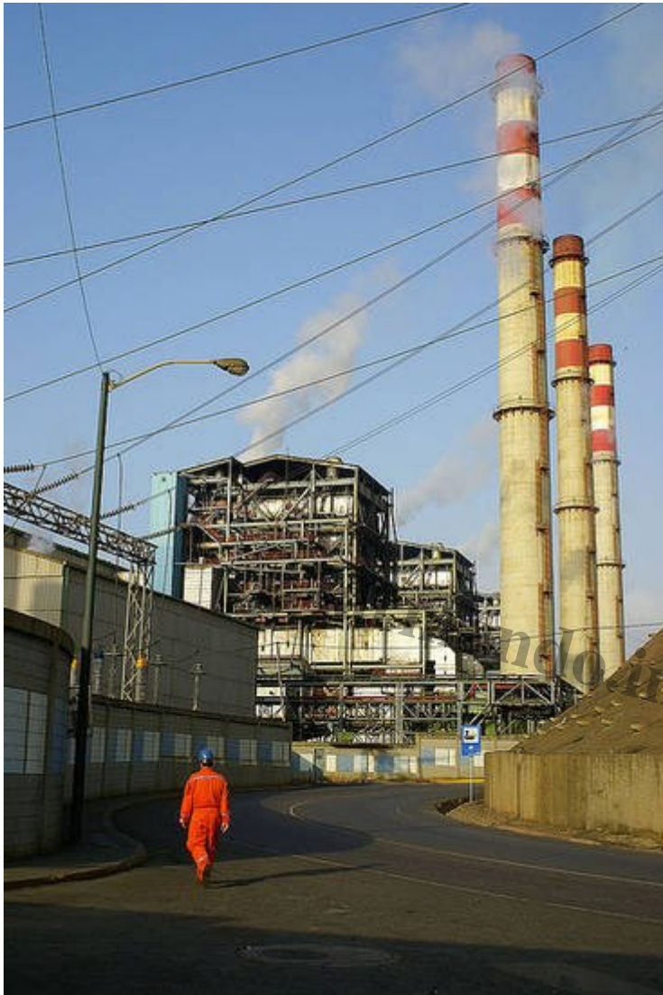
Imagen del complejo termoeléctrico de Tacoa. Foto: Flickr/Juan K.
