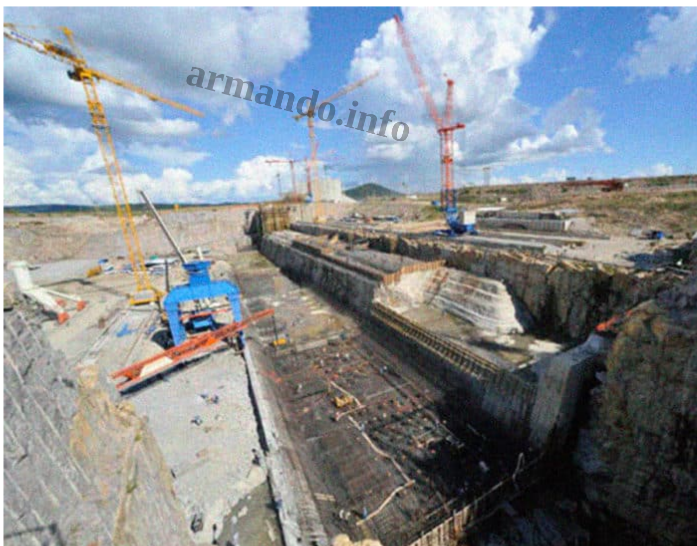
Manuel Castro Gómez y Yaika Aponte son esposos y directivos de Construcciones P&H, empresa contratada para realizar obras en la represa de Tocomá. Imagen tomada de corpoelec.gob.ve
